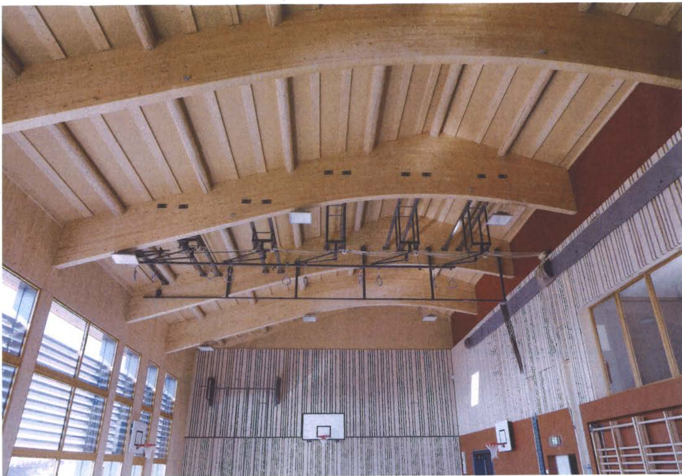
A l'intérieur, les poutres en toiture ont été laissées à l'état brut. Un aspect naturel avec tous ses noeuds et imperfections qui est voulu et assumé. Les enfants peuvent ainsi visualiser les troncs et garder à l'esprit que cette salle a été réalisée avec les arbres des forêts qui les entourent.
