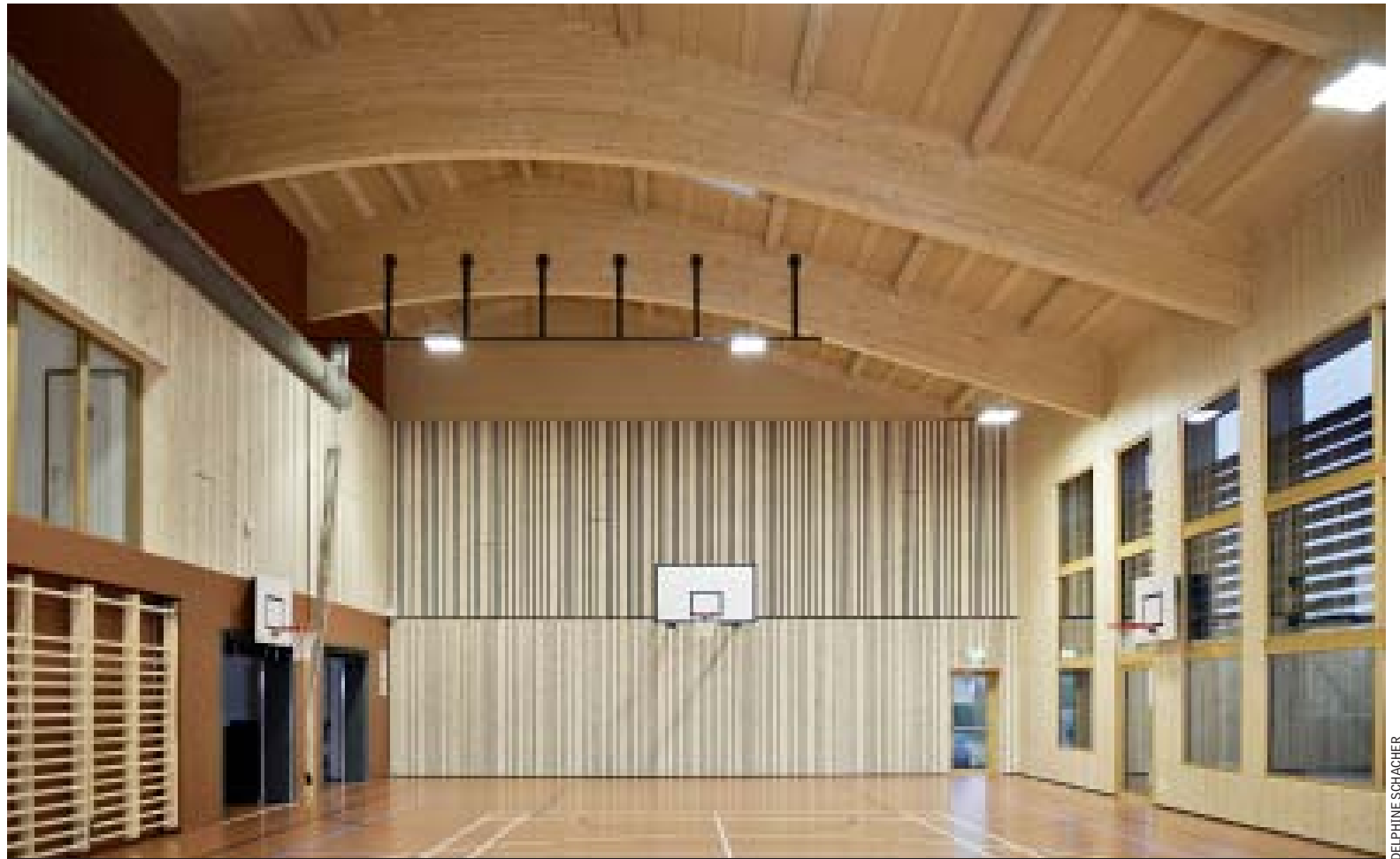
Pour la construction de la salle de sport de Bassins (VD), 185 m 3 de bois ont été mis en œuvre, dont 90% de bois suisse, principalement issu des forêts communales. L'ouvrage dispose du certificat d'origine bois suisse (COBS).
