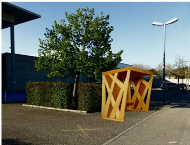
Avis Nidum (nid d'oiseau en latin) prend en considération l'espace existant en y installant une structure en trapèze. Le nid d'oiseau forme l'aspect structurel et statique. Le toit à double pente inversée rappelle l'envol de l'oiseau. Les matériaux proposés sont le sapin pour la structure et le noyer comme remplissage qui assure le contraste en façades.
