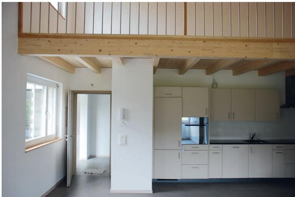
Pour répondre à la problématique environnementale, le bois, un matériau de proximité, est mis en œuvre. Présent dans le système structurel (dalle mixte bois-béton), il se rend ostentatoire en façade, par un bardage horizontal en sapin, et agrémente l'ambiance intérieure, avec
