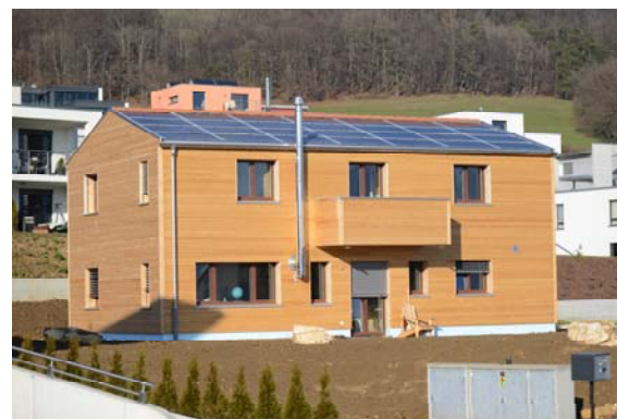
Villa Urfer à Delémont. Ce bâtiment fait l'objet d'une fiche de référence, téléchargeable sur notre site.
