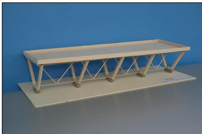
Le projet est basé sur la simplicité et il offre de l'espace. La structure est composée de cinq fermes préfabriquées et identiques. Elles sont reliées entre elles grâce à des poutres qui soutiennent également le toit. Les fermes sont fixées sur des éléments métalliques reposant eux-mêmes sur des fondations en béton.
