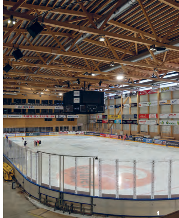
4 Fachwerkträger aus Fichten- und Eschenholz spannen sich 45 Meter über den Boden. Der Einsatz von Laubholz in der Konstruktion erlaubt optimale Querschnitte und grosszügige Spannweiten.
